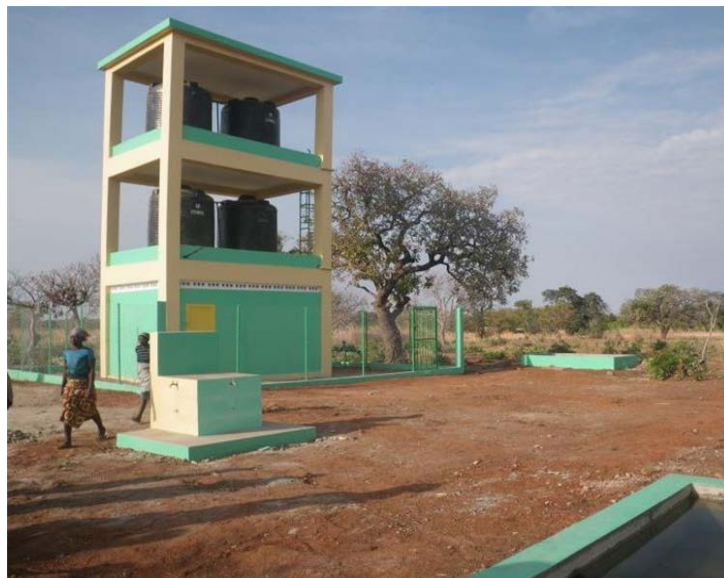
Image 1 : Système de pompage solaire d'eau pour le maraîchage et l'abreuvement des bovins construit à Tagayè dans la Commune de Natitingou
