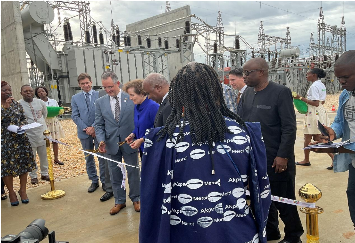
Image 6 : Inauguration du nouveau Transformateur T7 postes de Vèdoko (161/63kv-150 MVA)
